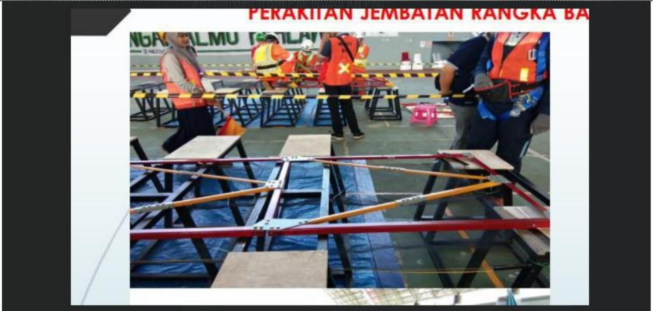
J Pada gambar tsb tampak perancah dan bagian struktur jembatan yg dirangkai di atasnya
